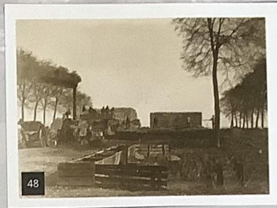
Strobalen maken met de stoommachine in de Wilhelminapolder in 1900
