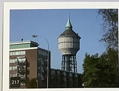
Toen de watertoren niet meer nodig was, bouwden men kantoren in het reservoir, waarvan naderhand woonappartementen zijn gemaakt
