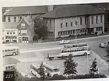
De inrichting van de telefooncentrale duurde langer dan de bouw
