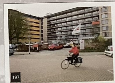
Het Gasthuis op de nieuwe locatie wordt in 2021 in delen gesloopt en weer nieuw opgebouwd
