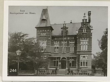
De in 1886 gebouwde Villa was vijftig jaar, tot 1972, het kantoor van de Keuringsdienst van Waren en daarna vele jaren de Muziekschool
