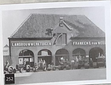
Het bedrijfspand van Franken & Van Weel aan de Singelstraat
