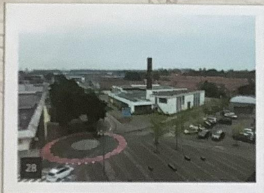
Van de in 1977 gesloten melkfabriek Hollandia bleef een deel van de schoorsteen staan
